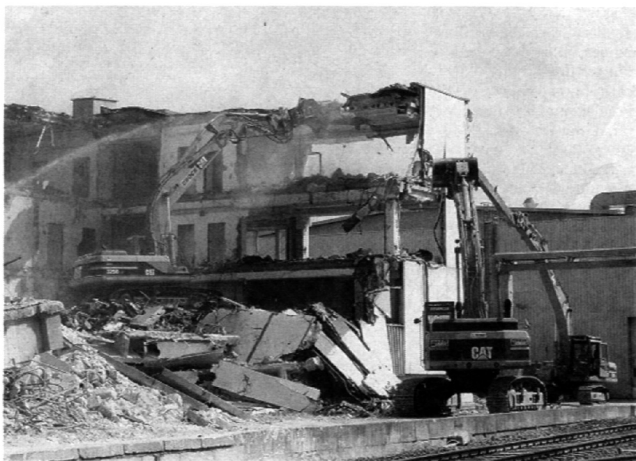
Abbruch an den stehengebliebenen Gebäudeteilen der Produktionshalle. Foto: Bock
