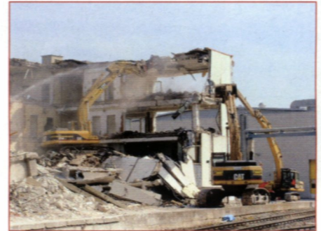
Abbruch an den stehen gebliebenen Gebäudeteile der Produktionshalle.
