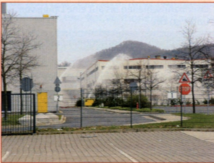
Die 11.000 m 2 Produktionshalle E 65 kurz vor der Sprengung.
