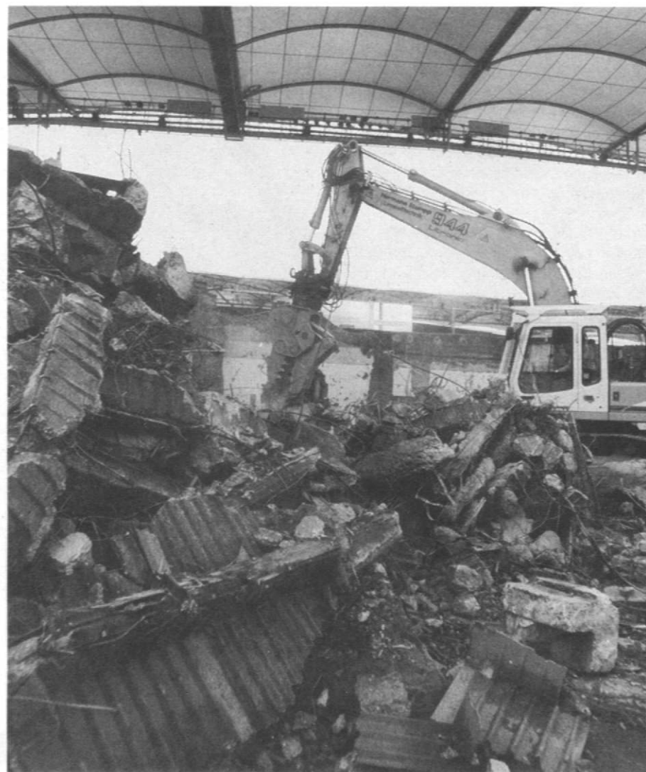
Bereits drei Wochen vor dem geplanten Ende war die Firma Hermann Stumpff mit den Abbrucharbeiten fertig, obwohl die gealterte, unterschiedlich beschaffene Bausubstanz die Arbeiten nicht gerade erleichterte.
