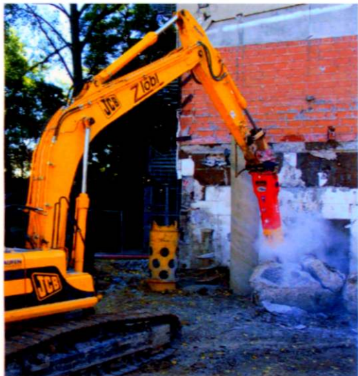
Zlöbl setzt die neuesten Abbruchhämmer von Steck ein.
