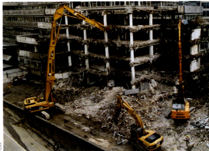
GL-Abbruch setzt am Kronprinzbau auf moderne Abbruchtechnik.
