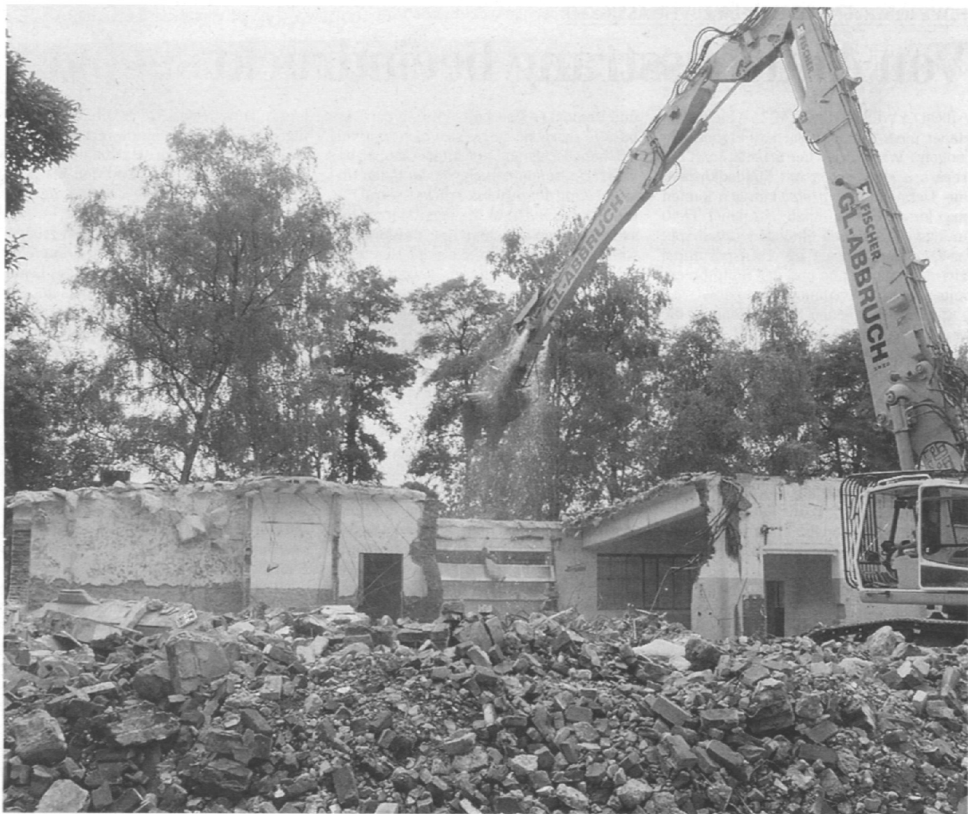
Rund 30 000 t Ziegelbruch konnten in umliegenden Deponien direkt für den Wegebau verwendet werden.
