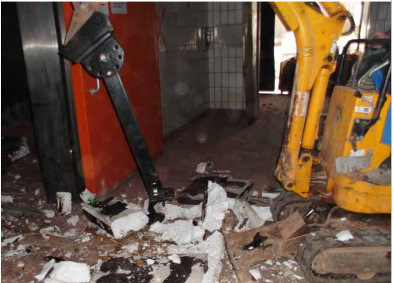
Reißzahn kann auf gleicher Aufnahme wie Abbruchlanze montiert werden.
